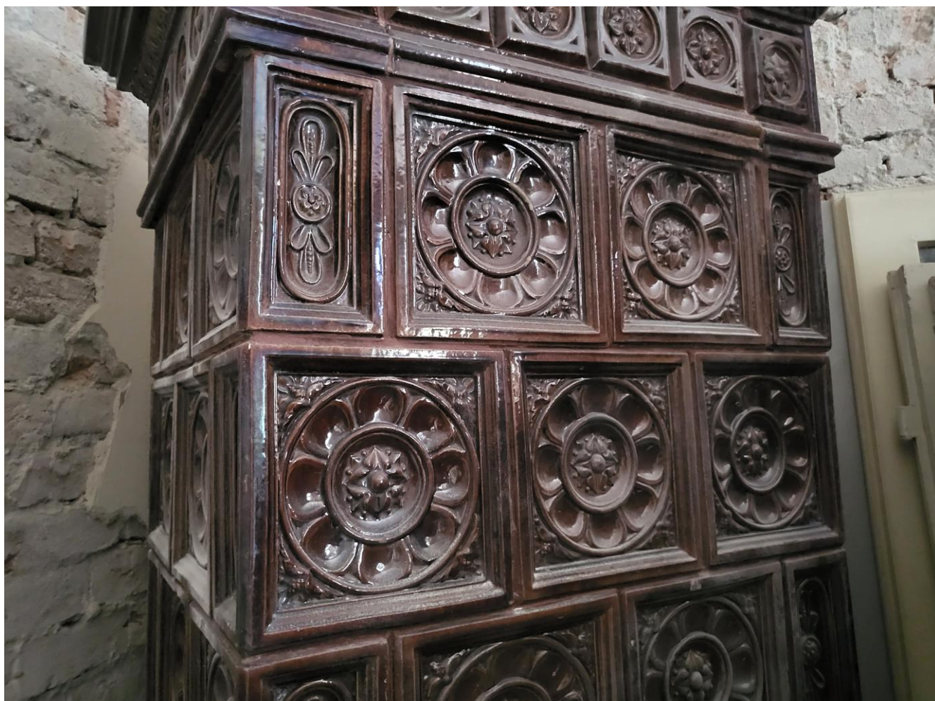
FOTOGRAFIJA 17 Detalj gornjeg dijela KAMINA 3 sa vidljivim oštećenjima i izmaknutim fugama u izvornom? postavljanju ili naknadnom preslagivanju kamina. Fotografirano u lipnju 2023. godine.
