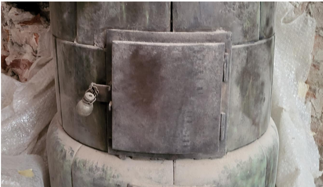
FOTOGRAFIJA 34 Detalj donjeg dijela KAMINA 5 unutar zone ložišta. Fotografirano u lipnju 2023. godine.
