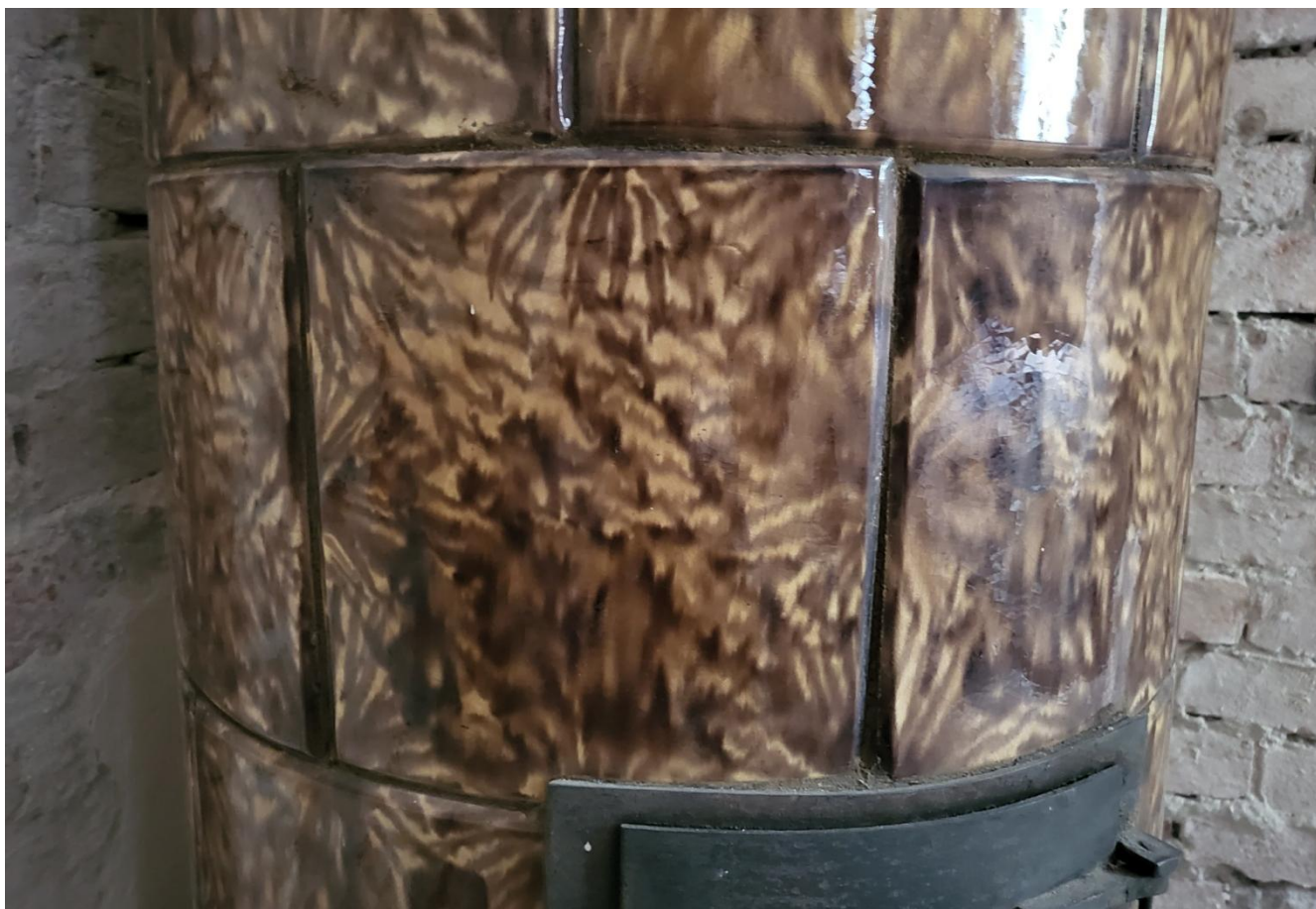
FOTOGRAFIJA 5 Detalj donjeg dijela KAMINA 1 sa vidljivim oštećenjima unutar zona fuga. Fotografirano u lipnju 2023. godine.
