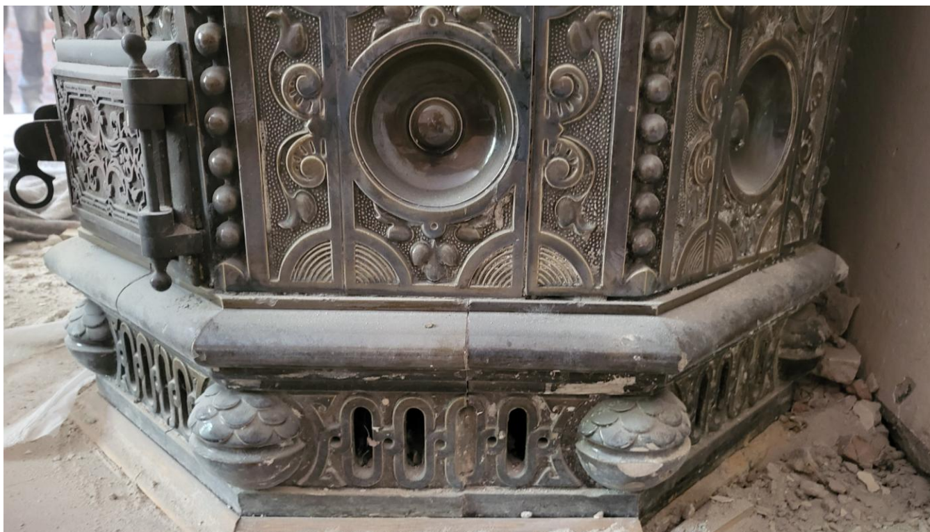
FOTOGRAFIJA 27 Detalj donjeg dijela KAMINA 4 unutar zone ložišta. Fotografirano u lipnju 2023. godine.
