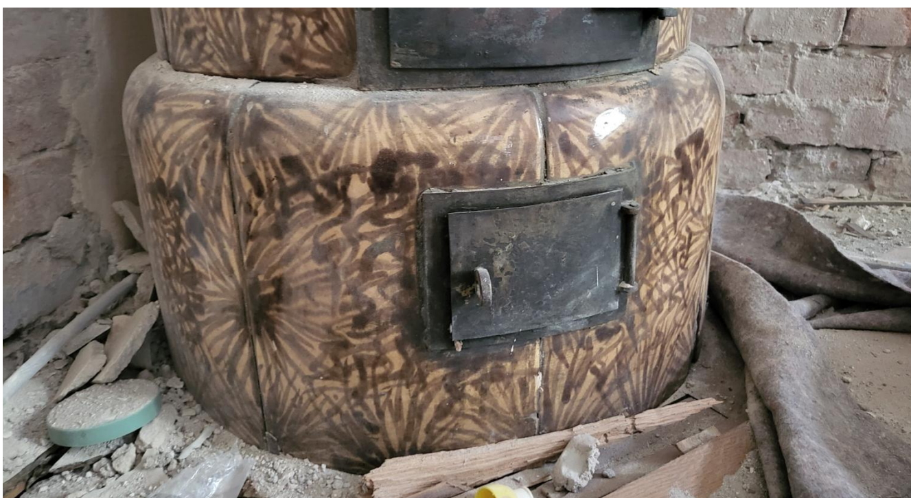
FOTOGRAFIJA 7 Detalj donjeg dijela KAMINA 1 ispod zone ložišta i vidljivim otvorom za skupljanje pepela. Fotografirano u lipnju 2023. godine.
