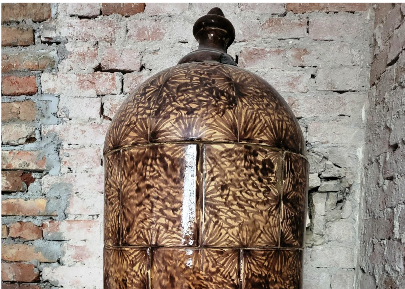
FOTOGRAFIJA 3 Detalj gornjeg dijela KAMINA 1 sa vidljivim oštećenjima i izmaknutim fugama. Fotografirano u lipnju 2023. godine.
