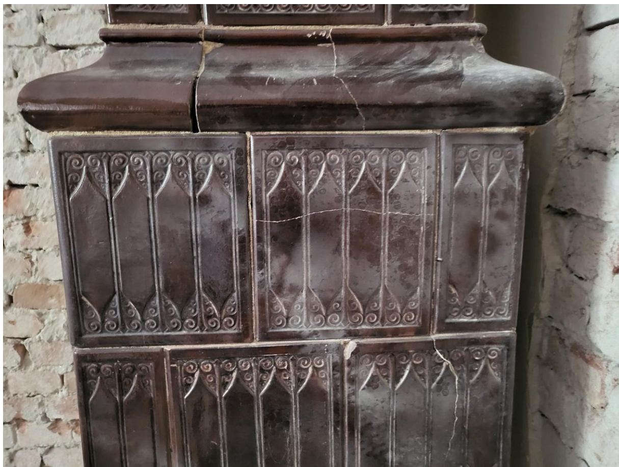
FOTOGRAFIJA 12 Detalj srednjeg dijela KAMINA 2 sa vidljivim slomljenim i popucalim elementima vjerojatno uslijed potresa. Fotografirano u lipnju 2023. godine.
