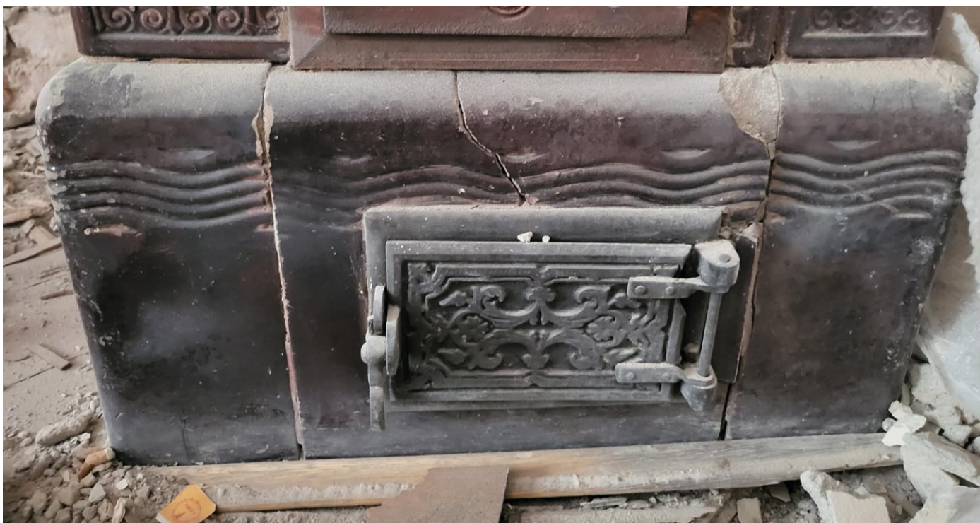
FOTOGRAFIJA 14 Detalj donjeg dijela KAMINA 2 ispod zone ložišta i vidljivim otvorom za skupljanje pepela. Fotografirano u lipnju 2023. godine.
