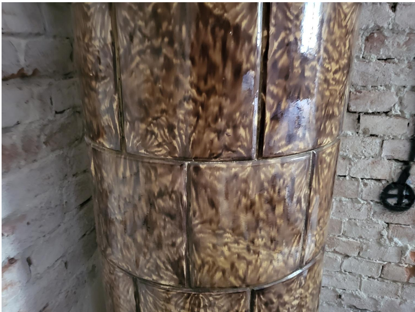
FOTOGRAFIJA 4 Detalj srednjeg dijela KAMINA 1 sa vidljivim oštećenjima unutar zona fuga. Fotografirano u lipnju 2023. godine.
