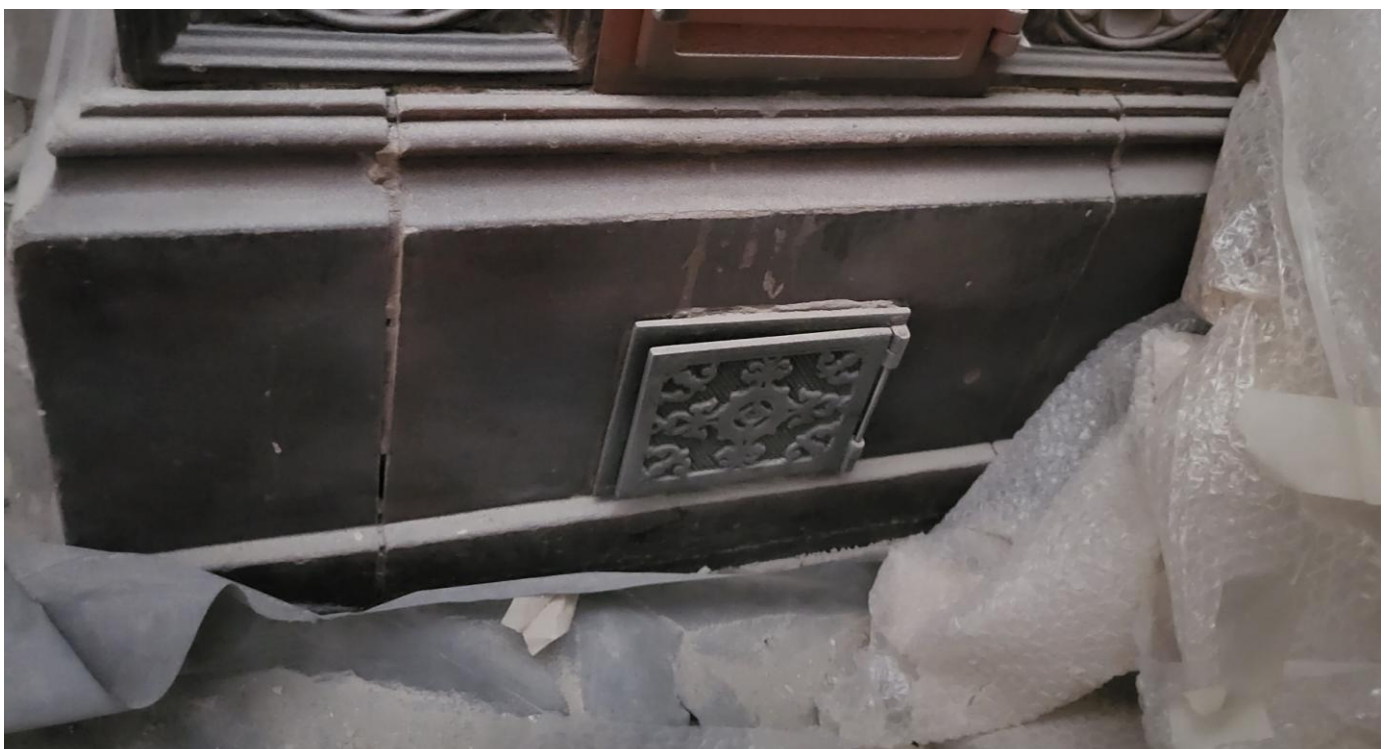
FOTOGRAFIJA 21 Detalj donjeg dijela KAMINA 3 ispod zone ložišta i vidljivim otvorom za skupljanje pepela. Fotografirano u lipnju 2023. godine.
